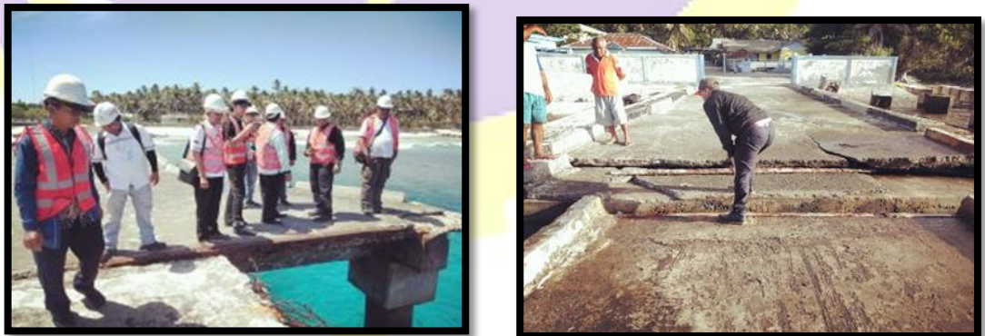
Gambar II – 17 : Monitoring Lapangan Kegiatan Replacement Pembangunan Fasilitas Pelabuhan Laut Miangas
