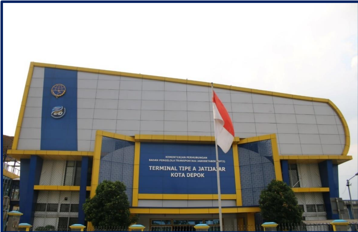
Gambar 6. 2 Gedung Terminal Tipe A Jatijajar
