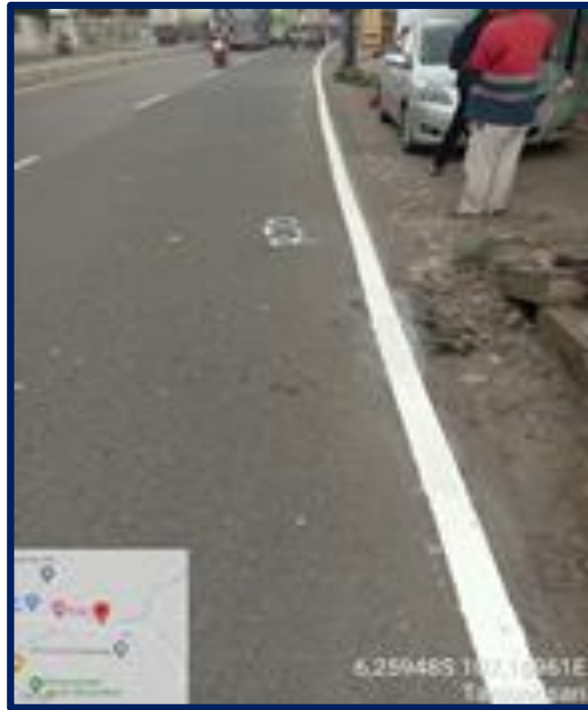
Gambar 5. 5 Marka Jalan di Kabupaten Bekasi, Cikarang (Kab. Bekasi - Kab. Karawang)
