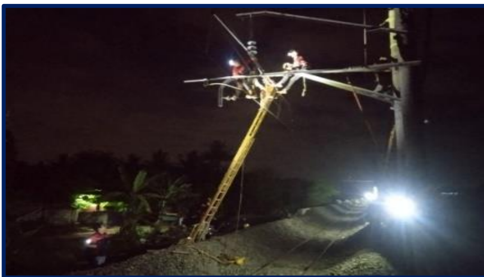
Gambar 4. 5 Pengangkatan Listrik Aliran Atas
