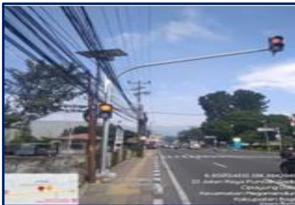
Gambar 5. 2 Warning Light di Jalan Raya Ciawi – Puncak, Kabupaten Bogor, Jawa Barat
