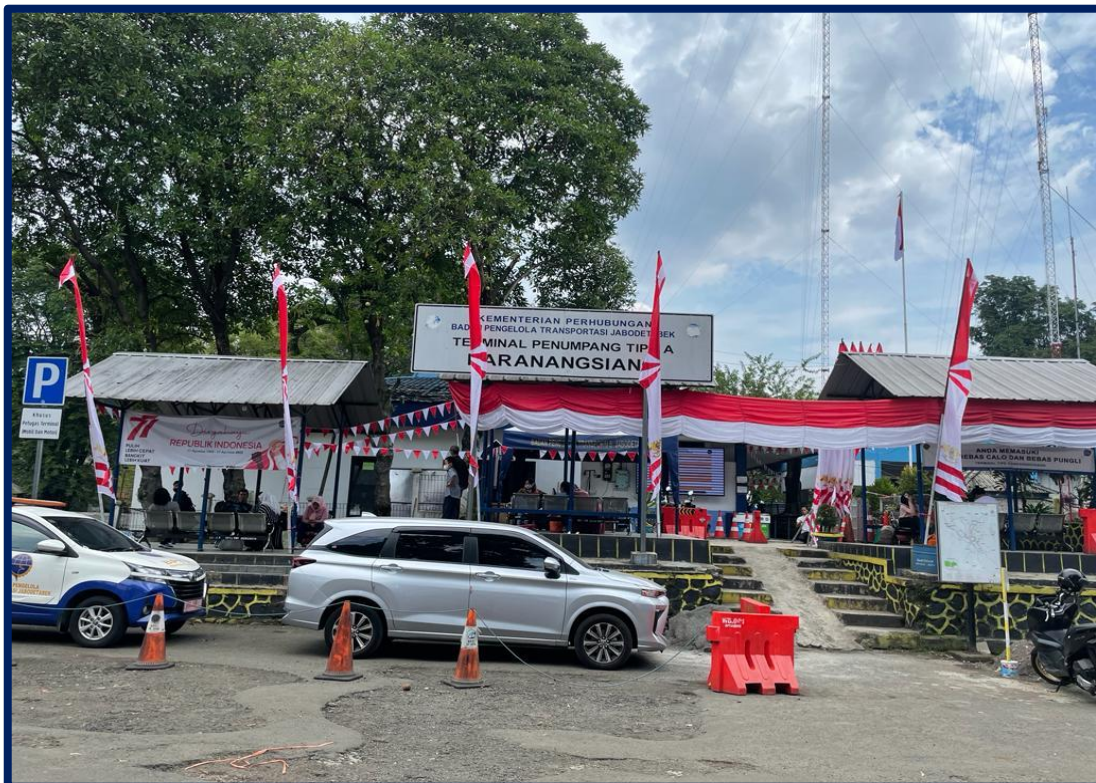
Gambar 6. 3 Gedung Terminal Tipe A Baranangsiang
