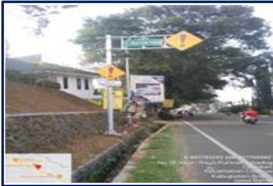
Gambar 5. 3 Rambu Overhead di Jalan Raya Ciawi – Puncak, Kabupaten Bogor, Jawa Barat
