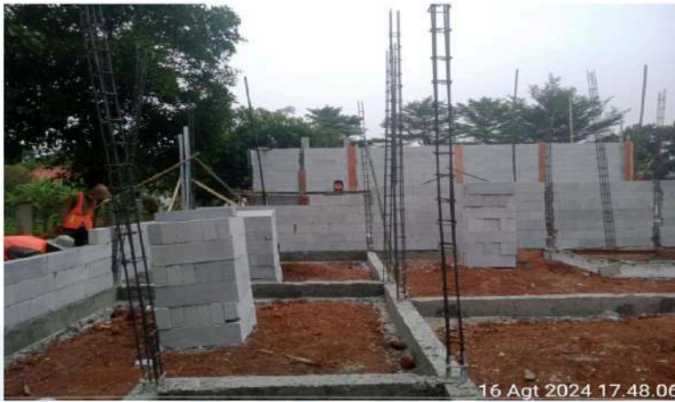
GAMBAR 1 – PASANGAN DINDING HEBEL RUMAH DINAS ESELON 3
