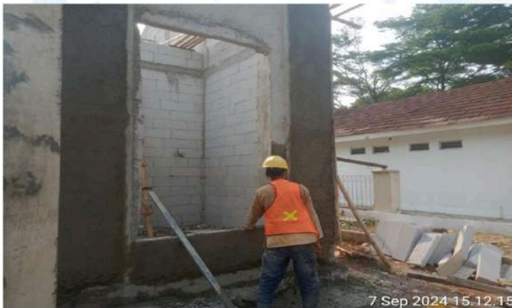
GAMBAR 4 – PLESTER DINDING DEPAN RUMAH DINAS ESELON 3
