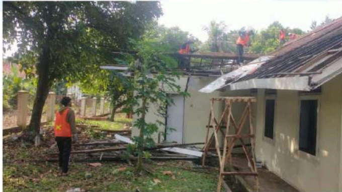
GAMBAR 2 – PEMBONGKARAN KASO RENG BANGUNAN EKSESTING
