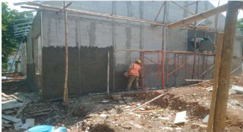
GAMBAR 4 – PLESTERAN DINDING SAMPING RUMAH DINAS ESELON 3
