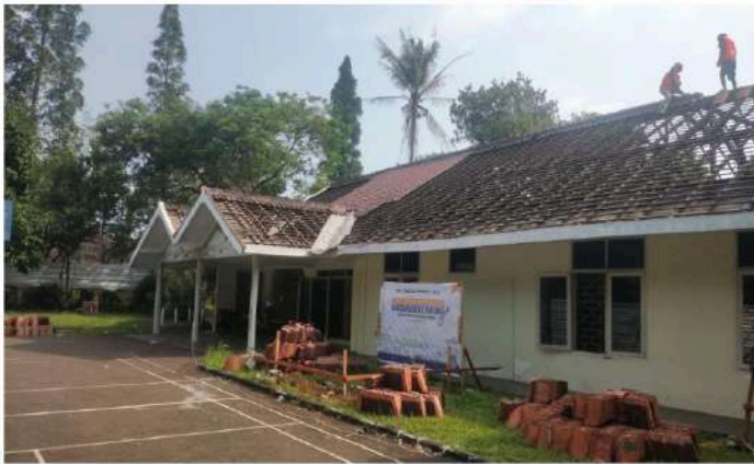
GAMBAR 1 – PEMBONGKARAN ATAP BANGUNAN EKSESTING
