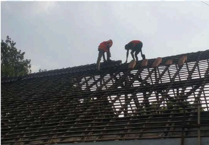
GAMBAR 4 – PEMBONGKARAN NOK KARPUSAN BANGUNAN EKSESTING
