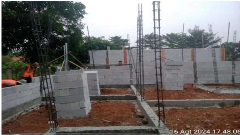
GAMBAR 3 – PASANG DINDING HEBEL DAN BESI KOLOM
