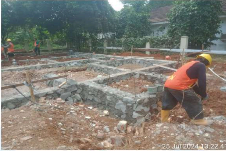
GAMBAR 1 – PASANG PONDASI RUMAH DINAS ESELON 3
