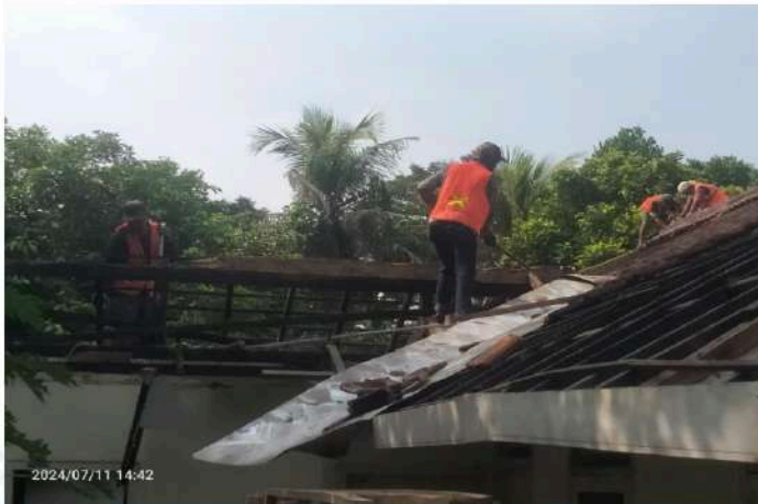
GAMBAR 3 – PEMBONGKARAN TALANG JURAI BANGUNAN EKSESTING
