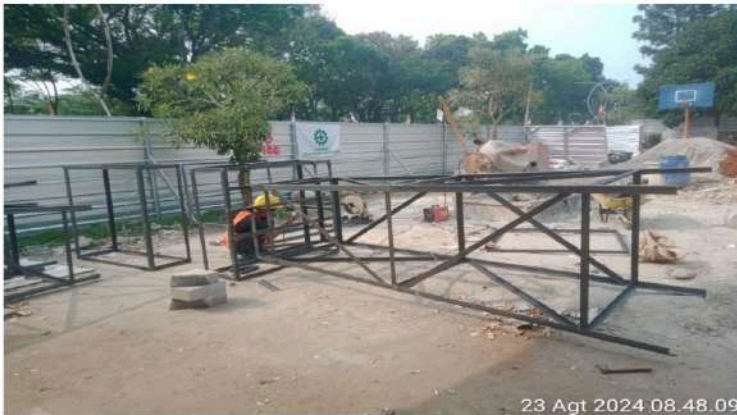
GAMBAR 1 – PABRIKASI MENARA TOREN
