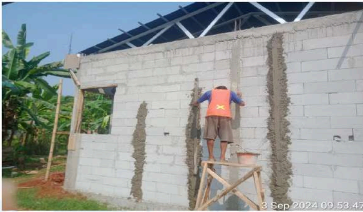
GAMBAR 3 – PASANG KEPALAAN PLESTERAN DINDING RUMAH DINAS PEGAWAI
