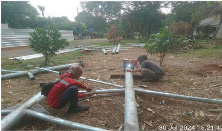
GAMBAR 4 – PABRIKASI TIANG PARKIRAN
