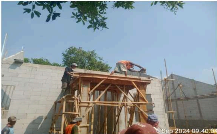
GAMBAR 3 – PENGECORAN DAK TERAS RUMAH DINAS ESELON 3
