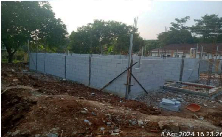
GAMBAR 4 – PASANG DINDING HEBEL RUMAH DINAS ESELON 3
