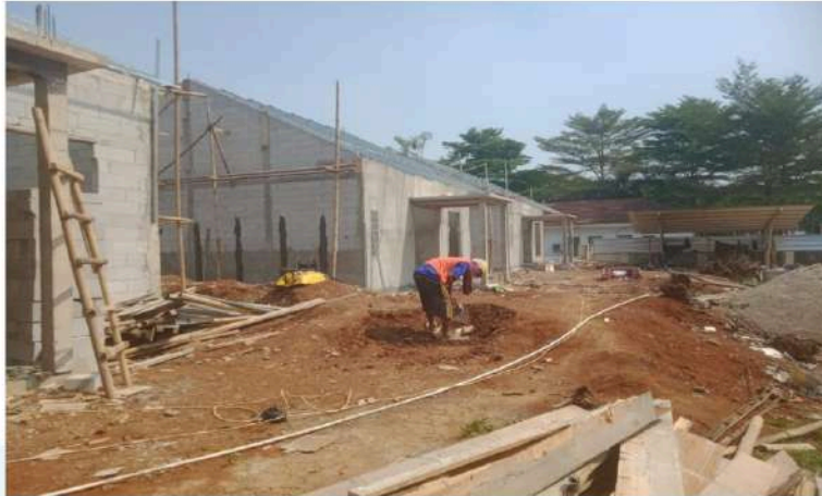
GAMBAR 5 :PENGURUGAN PENINGGIAN LANTAI RUMAH DINAS ESELON 3
