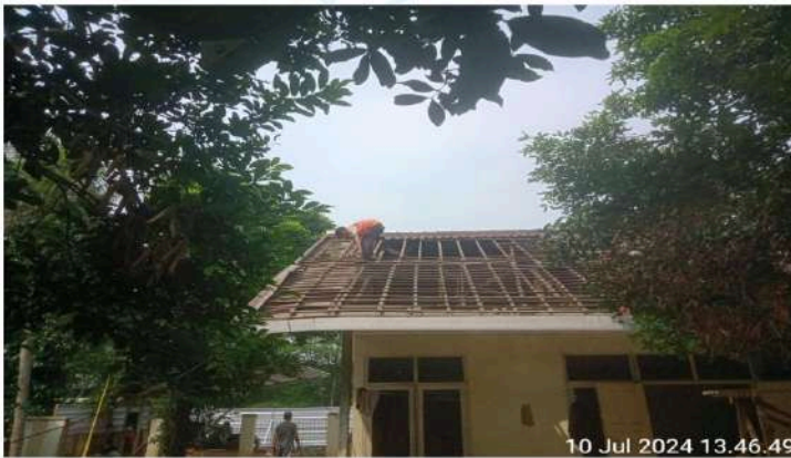
GAMBAR 6 – PEMBONGKARAN BANGUNAN ( RUMAH ESELON III )
