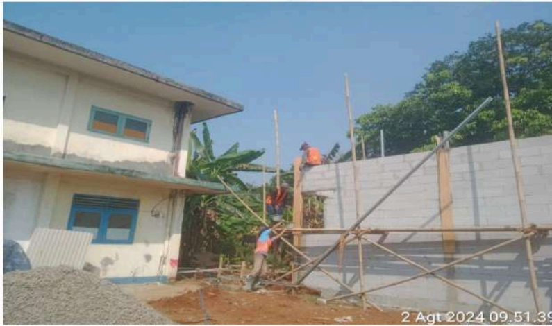
GAMBAR 4 – PASANG DINDING HEBEL RUMAH DINAS PEGAWAI
