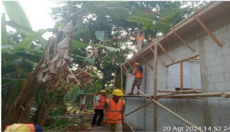
GAMBAR 2 – PASANG BEKISTING DAK ATAP RUMAH DINAS PEGAWAI
