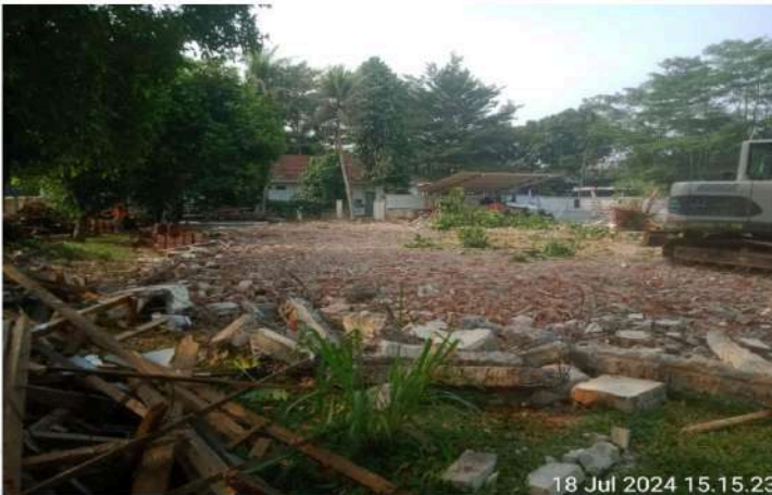
GAMBAR 1 – PEMBONGKARAN GEDUNG BANGUNAN EKSISTING
