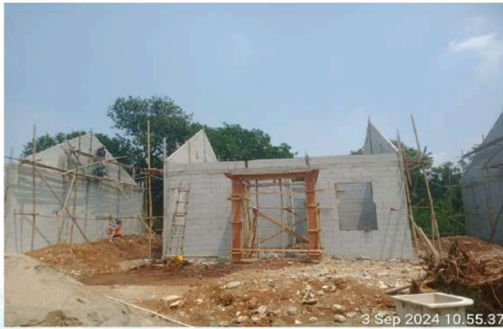
GAMBAR 5 – PEMASANGAN BEKISTING DAK TERAS RUMAH DINAS ESELON 3
