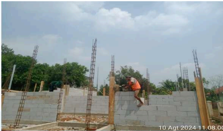
GAMBAR 3 – PASANG DINDING HEBEL DAN BEKISTING KOLOM
