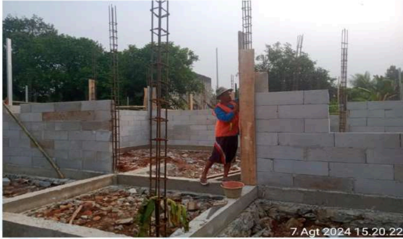
GAMBAR 3 – PASANG DINDING HEBEL DAN BEKISTING KOLOM
