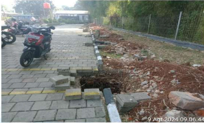
GAMBAR 1 – PENGECORAN LANTAI KERJA PARKIRAN
