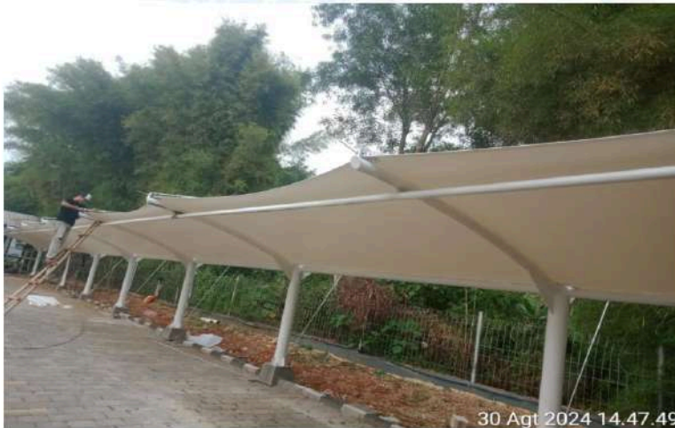
GAMBAR 4 – PASANG ATAP MEMBRAN PARKIRAN
