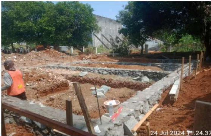
GAMBAR 3 – PASANG PONDASI RUMAH DINAS ESELON 3
