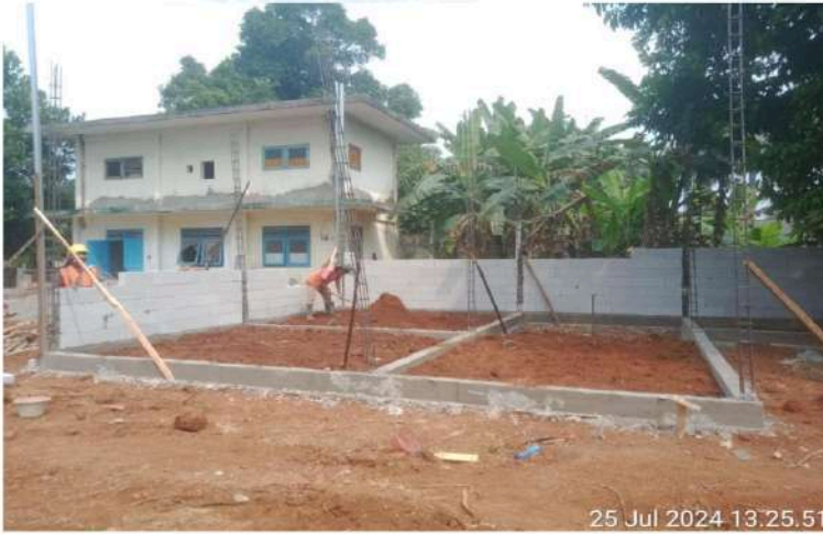
GAMBAR 2 – PASANG DINDING HEBEL RUMAH DINAS ESELON 3
