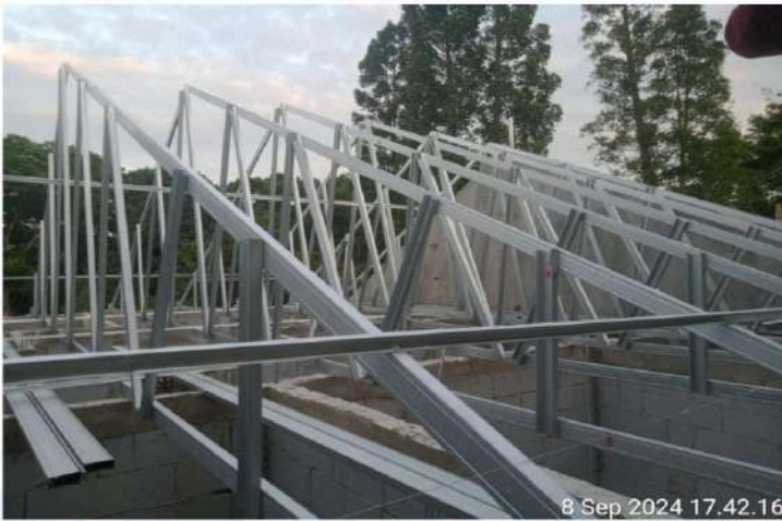
GAMBAR 5 – PEMASANGAN ATAP BAJA RINGAN RUMAH DINAS ESELON 3
