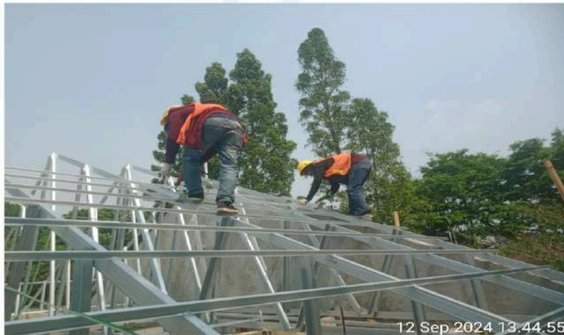
GAMBAR 2 – PASANG ATAP BAJA RINGAN RUMAH DINAS ESELON 3
