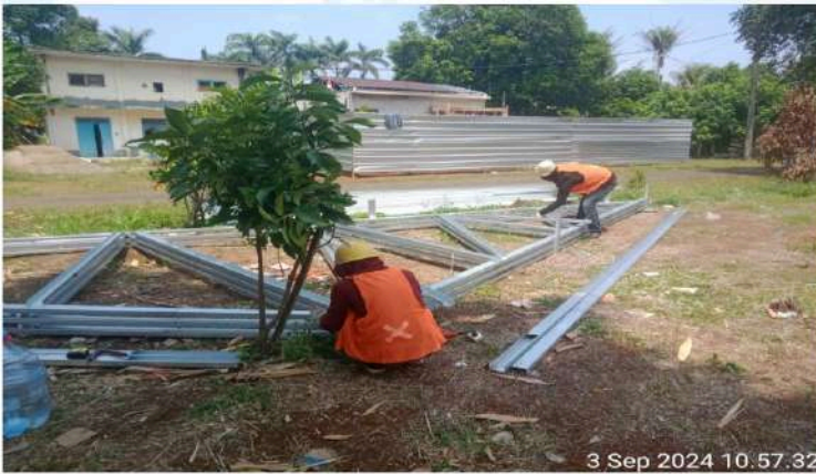
GAMBAR 4 – PABRIKASI ATAP BAJA RINGAN RUMAH DINAS ESELON 3
