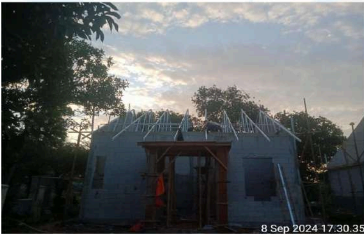
GAMBAR 6 – PEMASANGAN ATAP BAJA RINGAN RUMAH DINAS ESELON 3
