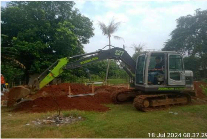
GAMBAR 2 – GALIAN PONDASI RUMAH DINAS PEGAWAI
