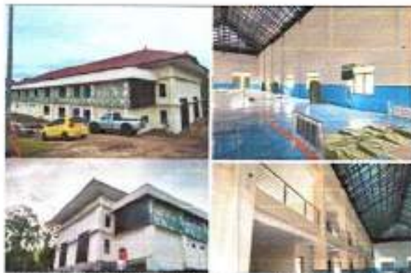
Gambar 4. 62 Pembangunan Gedung Laboratorium
