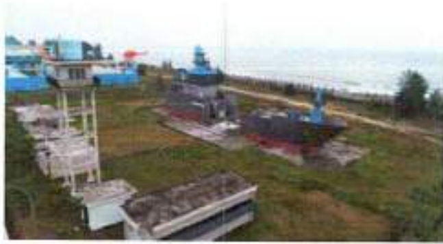
Gambar 4. 18 Fire Ground, Menara Air, Ruang Pompa dan Ruang Genset
