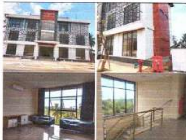
Gambar 4. 63 Pembangunan Gedung Bimbingan Ketarunaan
