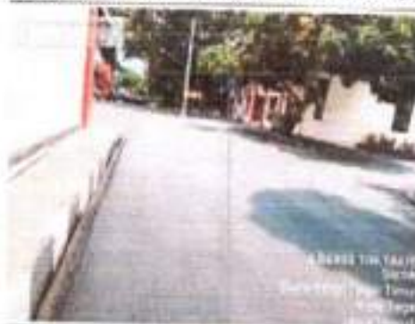
Gambar 4. 37 Perbaikan Jalan Lingkungan dan Pengaspalan Kampus 1 PKTJ
