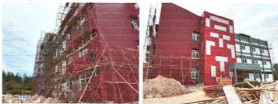
Gambar 4. 13 Gedung Asrama C
