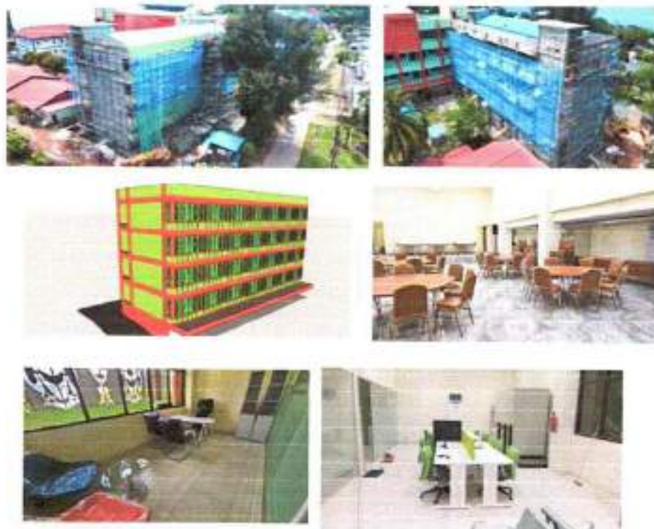
Gambar 4. 68 Pembangunan Gedung Kelas A
