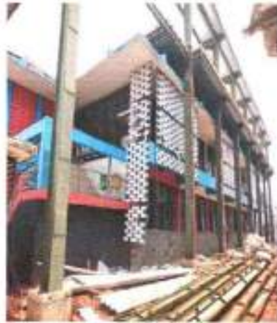
Gambar 4. 33 Pembangunan Asrama (a) Taruna Renovasi Ruang Makan, Dapur Dan Laundry (b)
