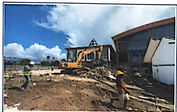
Pembongkaran Bnagunan Lama
