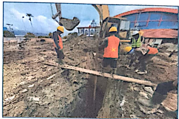
Pekerjaan Galian Pondasi
