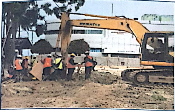
Pekerjaan Galian Pondasi
