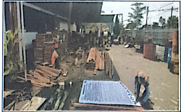
Pemasangan Spanduk K3
