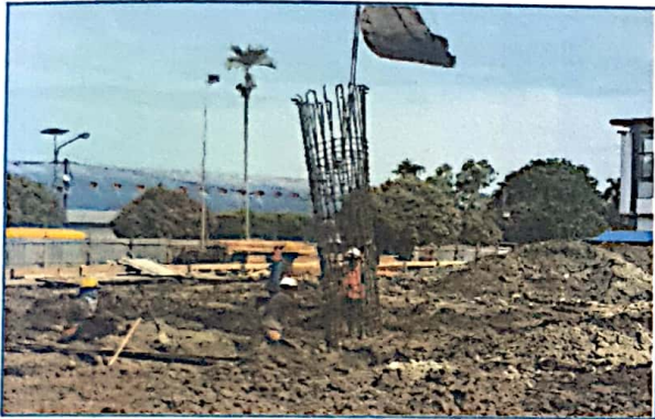
Pekerjaan Pemasangan Pembesian Sumuran
