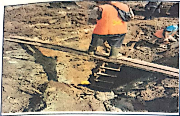
Pekerjaan Galian Pondasi Sumuran
