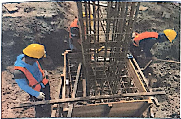
Pekerjaan Pemasangan Bekisting
