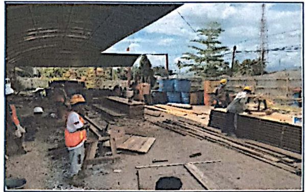
Pekerjaan Pabrikasi Bekisting
