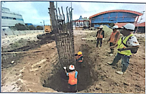
Pekerjaan Pemasangan Pembesian Pondasi
