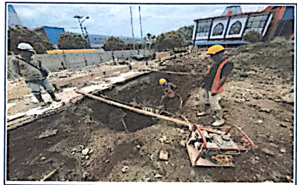
Pekerjaan Pengecoran Pondasi Sumuran
