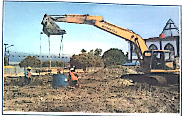
Pekerjaan Pemasangan Mall Pondasi Sumuran
