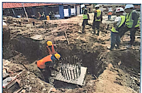
Pengecoran Pondasi
