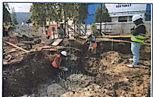
Pekerjaan Lantai Kerja File Cap
