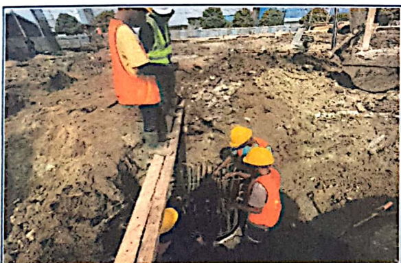
Pekerjaan Pemasangan Tulangan Pondasi
