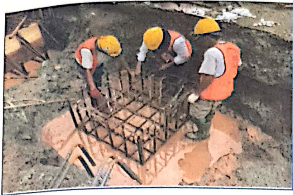
Pekerjaan Pembesian File Cap
