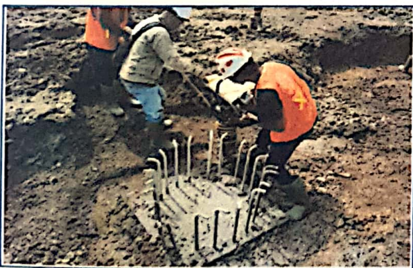
Pekerjaan Pemadatan Tanah
