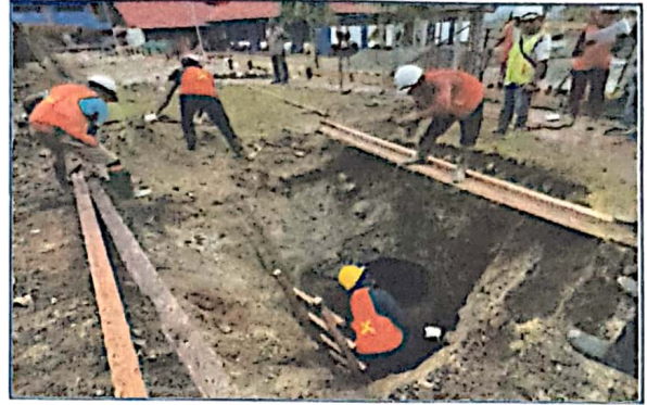
Pekerjaan Pemasang Mall Pondasi
