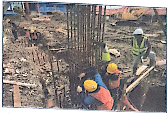
Pekerjaan Pemasangan Pembesian Kolom
