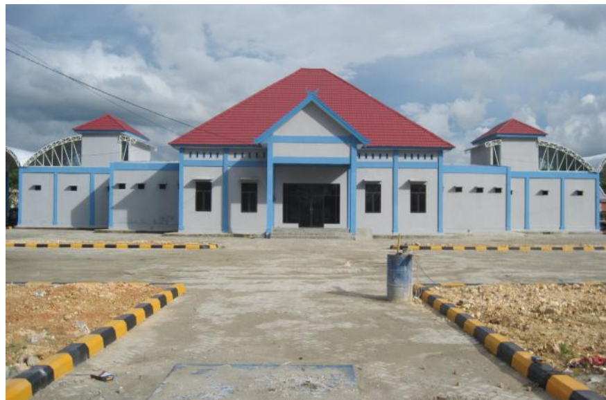
Gambar 3.2. Pembangunan Terminal Barru
