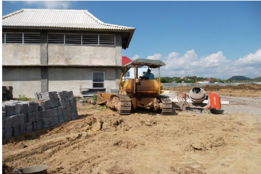
Gambar 3.3. Pembangunan Terminal Wonogiri
