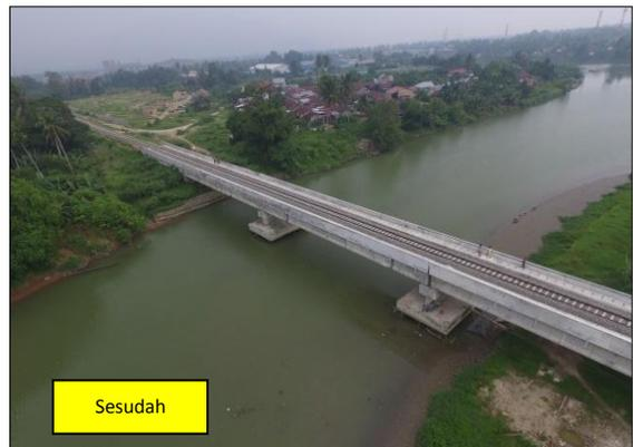
**Gambar 4.8.** Pemasangan Rel.R.54 pada Jembatan KA bentang 164,4 M (26,8x2+35.8x2 M)
