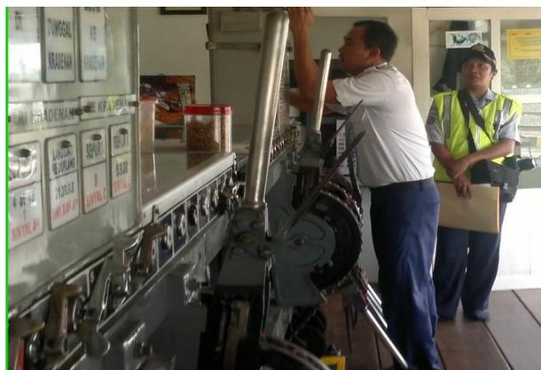
**Petugas PPKA Petak Jalan jambon-Sulur Mengoprasikan alat sinyal Mekanik**
