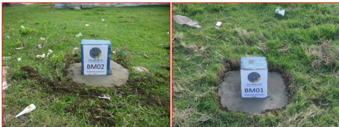
Gambar 25 Penempatan Bench Mark (BM 01 dan BM 02) Pelabuhan Laut Kobisadar
