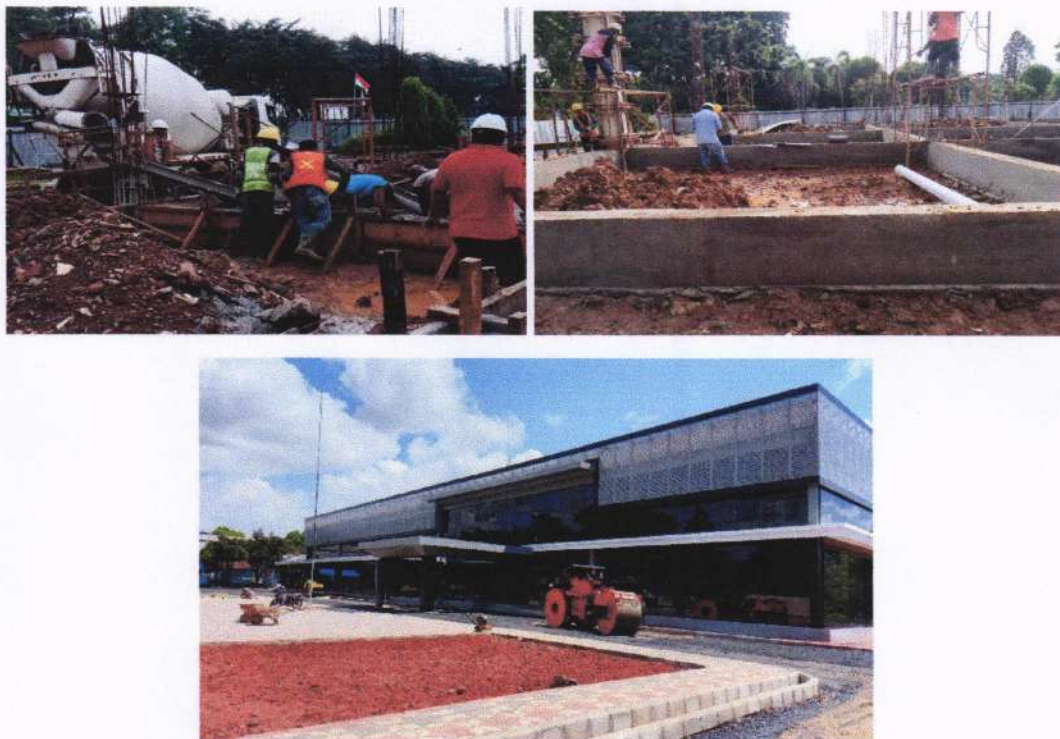
Gambar 2. 40 Pembangunan Gedung Utama Pusat Pengembangan SDM Perhubungan Udara
