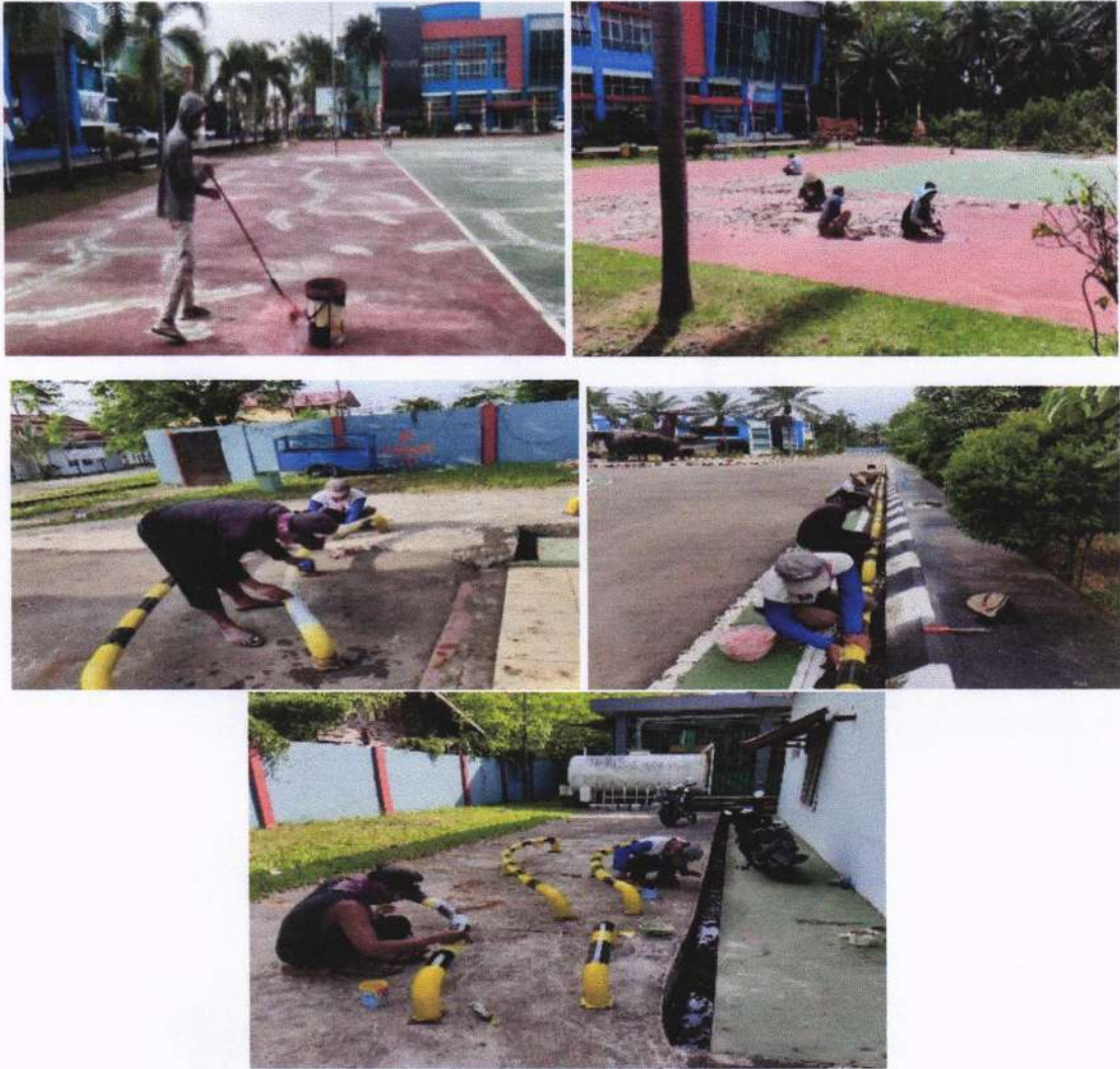
Gambar 2. 43 Pekerjaan Pengecatan marka jalan, kantin jalan dan selasar di kampus UPT Poltekbang Palembang
