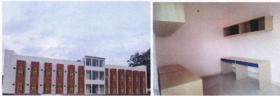
Gambar 4. 16 Pembangunan Asrama Alpha dan Asrama Bravo Curug I di kampus PPI-STPI Curug. Dan Pengadaan Meubelair Asrama
