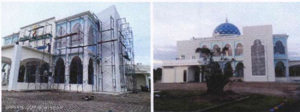
Gambar 4. 8 Renovasi masjid tempat ibadah kampus Polekpel Sumatera Barat
