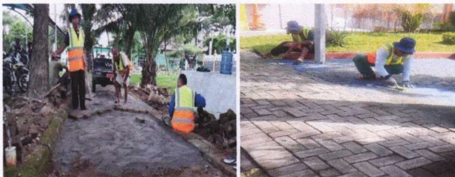
Gambar 2. 10 Pengecatan Trotoar jalan di lingkungan API Madiun
