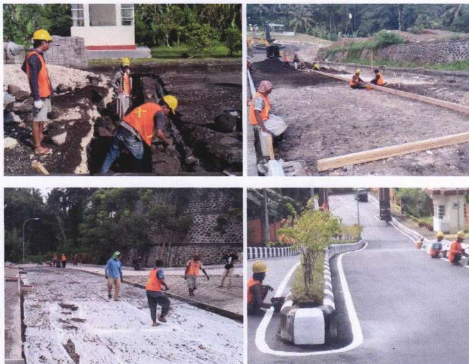
Gambar 2. 11 Pekerjaan Jaringan Jalan kampus PoliteknikTransportasi Bali
