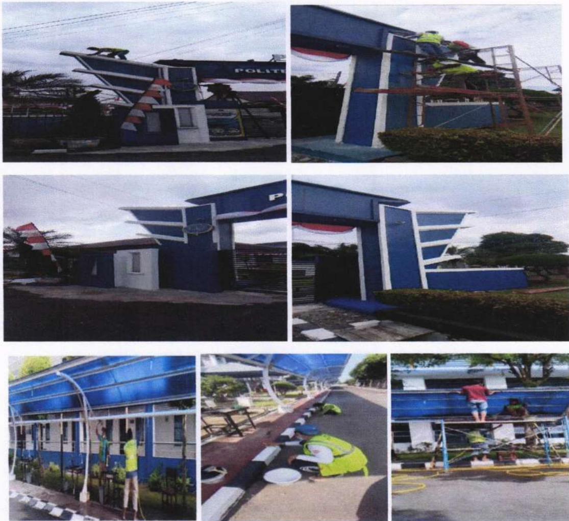
Gambar 2. 41 Pekerjaan Pembersihan Canopy dan Pengecatan Castin di Kampus Politeknik Penerbangan Medan
