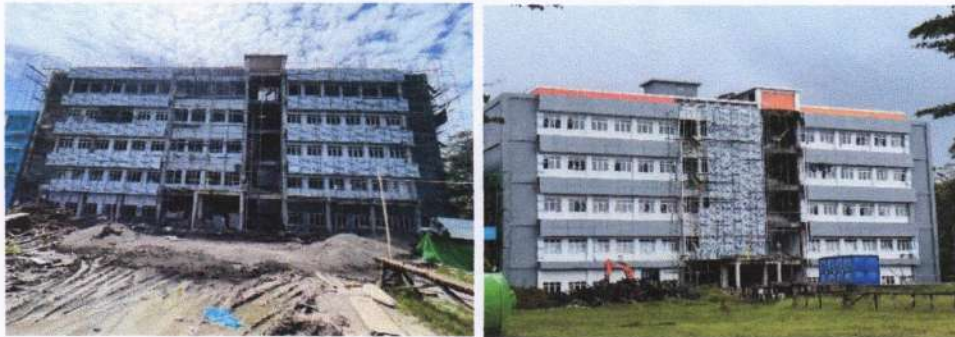
Gambar 4. 13 Pembangunan Gedung Asrama (Dolmitory) bertingkat 5 lantai kampus Poltekpel Sulut
