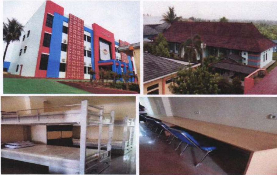
Gambar 4. 14 Renovasi Gedung kantor dan pengadaan meubeuler kampus Poltekbang Palembang.
