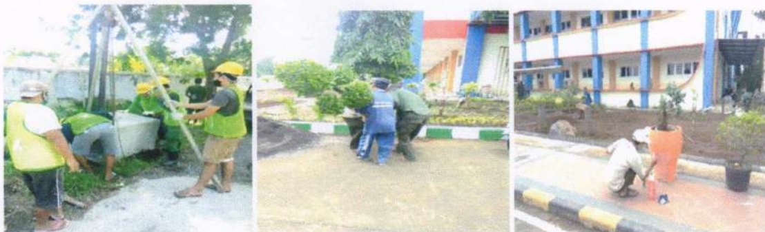
Gambar 2. 42 Pekerjaan Perapian Halaman di lingkungan kampus Poltekbang Surabaya
