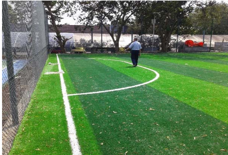
Gambar 2.13. Pembangunan lapangan futsal di PPSDM Perhubungan Udara
