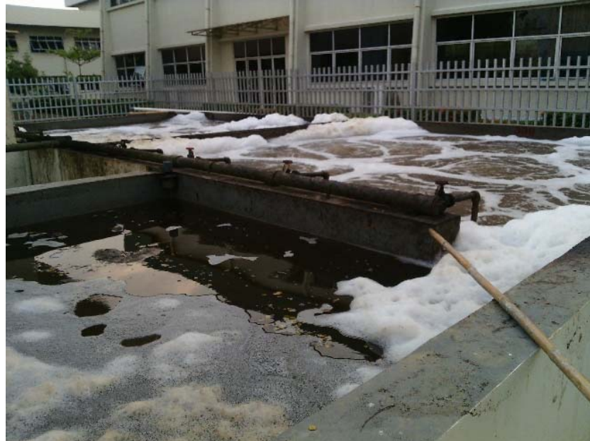
Gambar 2.12. Pengadaan instalasi pengolahan air limbah di BP2IP Tangerang
