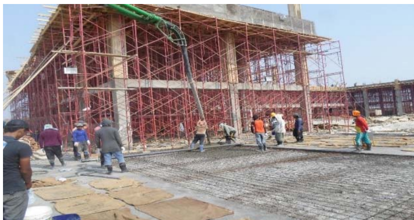
Gambar 2.14. Pembangunan hanggar dan apron di ATKP Makassar
